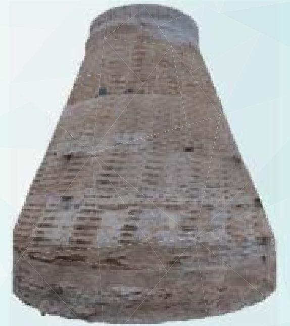
軸部φ2,600mm / 拡底部φ6,100mm 施工地盤：ローム・砂礫
