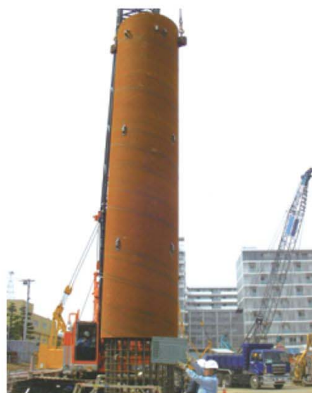
写真-1 KCTB 杭施工状況
