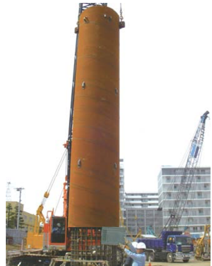
写真-1 KCTB 杭施工状況
